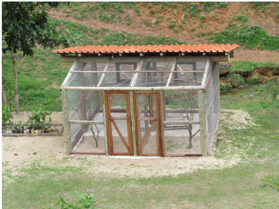
Figura 3: Viveiro de ambientação construído na RPPN Mata da Serra, município de Vargem Alta, ES.
